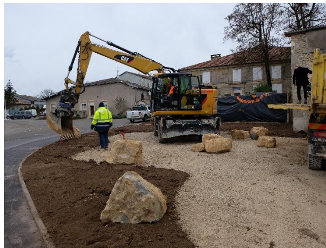
Terrassement de la place, rue de l'église à Pierrefitte-sur-Aire
