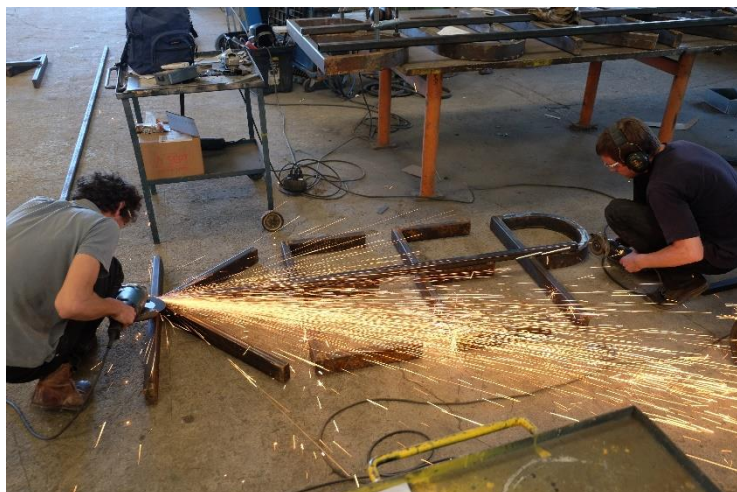
La chaudronnerie Rennesson Mathieu, à Saint-Mihiel (55), accueille Nøne Futbol Club pour la réalisation des lettres en acier.
