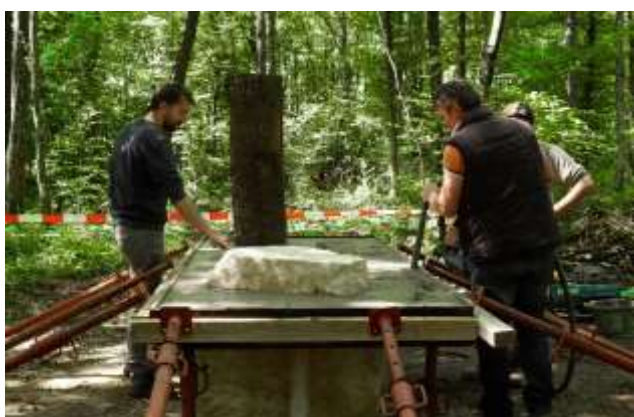
David de Tscharner, Nature Morte , coulage du béton avec les Chantiers du Barrois
