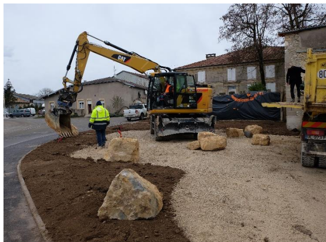
Terrassement de la place, rue de l'église à Pierrefitte-sur-Aire
