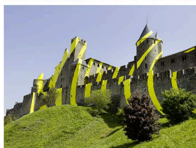
Felice VARINI, Cercles concentriques excentriques , 2018, peinture, Château et remparts de la ville de Carcassonne (France)
