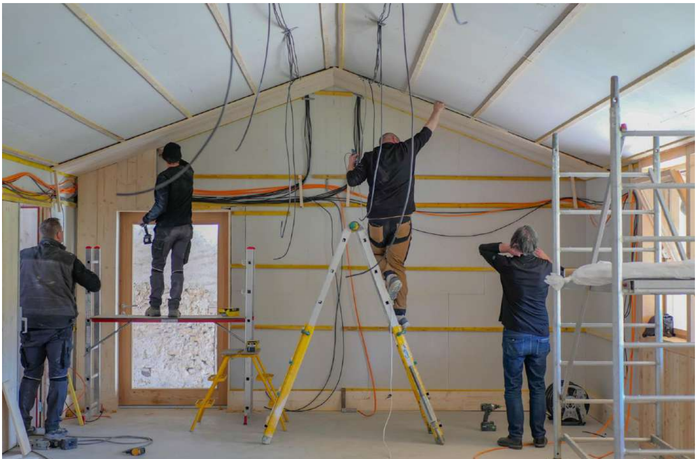
La Maison Vent des Forêts, travaux octobre 2025 © Olivier Dancy
