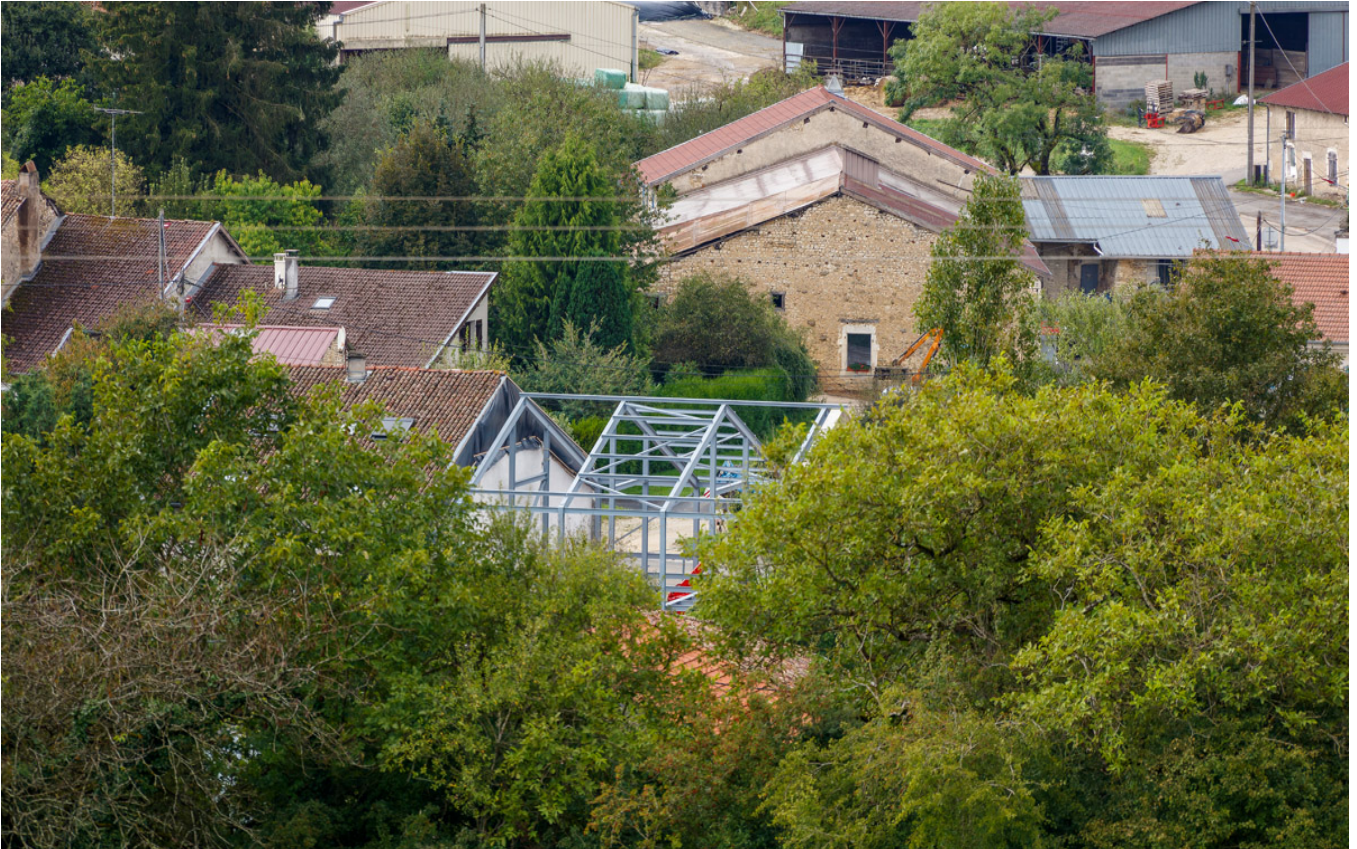
Maison Vent des Forêts, travaux octobre 2024, Lahaymeix (55) © Olivier Dancy
