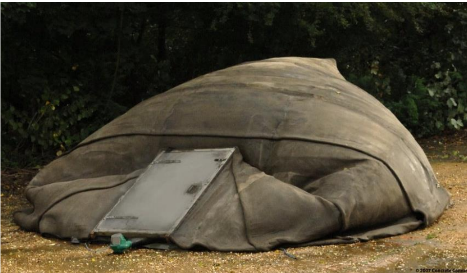
Abri humanitaire gonflable en toile enduite de béton
